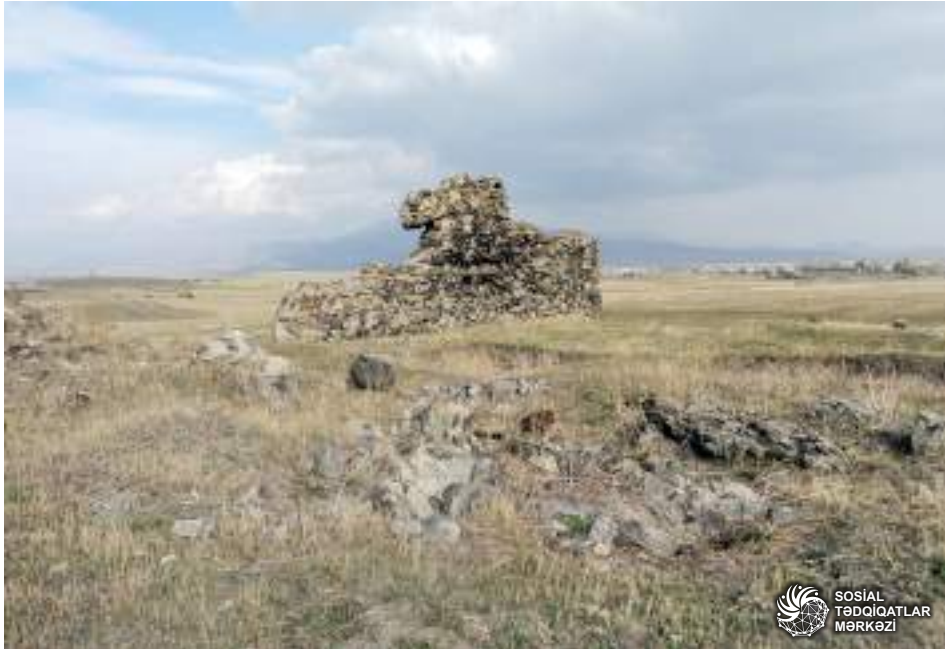
Kərbibasər mahalının Əştərək rayonunun Taliş kəndində karvansara (XIII əsr)
